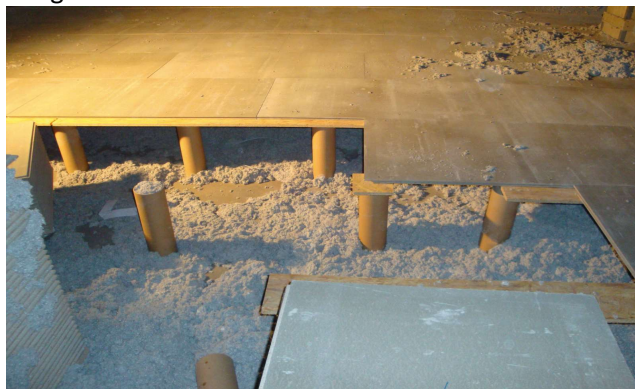
(oben) möglicher SOLL-Stand mit Einblasdämmung begebar
